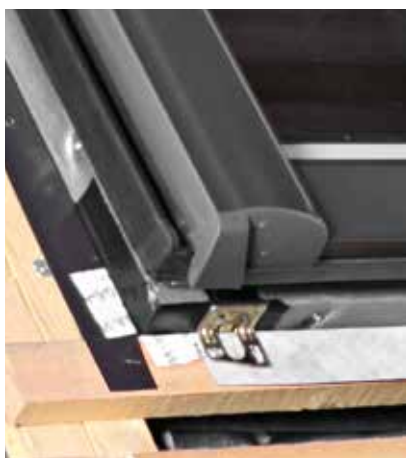
Wykonanie uszczelnienia wodoodporną taśmą dookoła okna.
