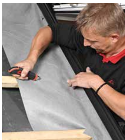
Montaż na łatach montażowych - połączenie wodoszczelne.
