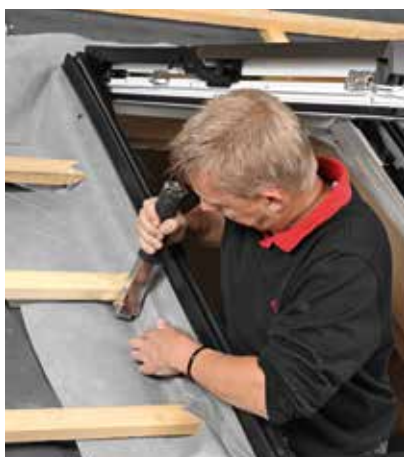
Montaż na łatach montażowych - połączenie wodoszczelne.
